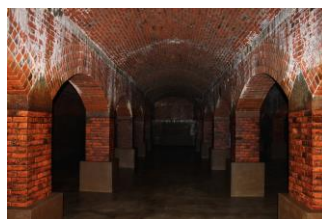
覆蓋付緩速ろ過池 (春光台配水場)
