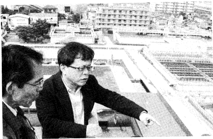
三園浄水場を熱心に視察する猪瀬副知事
