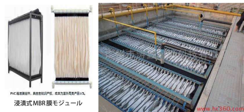
写真2 膜式活性汚泥法 (MBR膜)。沈降分離の代わりに高効率の膜分離を用いる (チャイナ・ウォーター・リサーチ提供)
