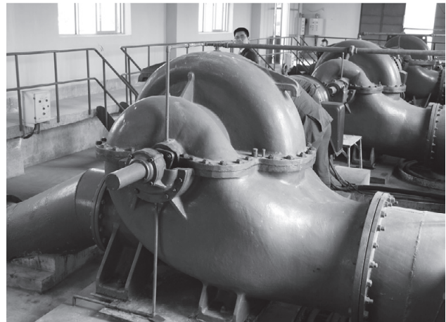
造水能力14万m 3 /日のアンズオン浄水場。ポンプは中国製(300kW)
