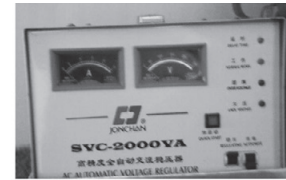
国から供給される220V, 60Hz 給電は2～4時間、さらに電圧、周波数の変動が激しいので自前で自動AC制御変圧器を設置
