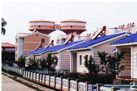
2. 近代共同農業団地の給水塔
