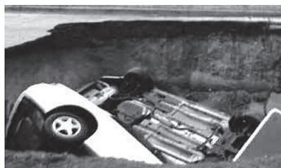
米国では、老朽化した水道管の破裂による道路陥没事故も起きている
