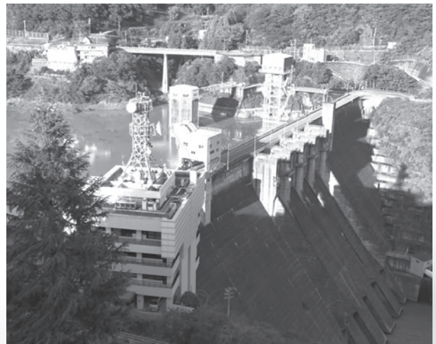
写真2 大渡ダム＝高知県仁淀川町（筆者撮影）
