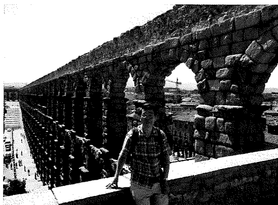
セゴビア水道橋
