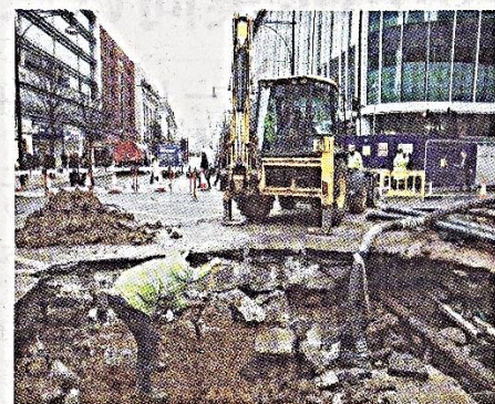
ロンドンのオックスフォード・ストリートで水漏れを修理する作業を行うテムズ・ウォーターの従業員（ブルームバーグ）
