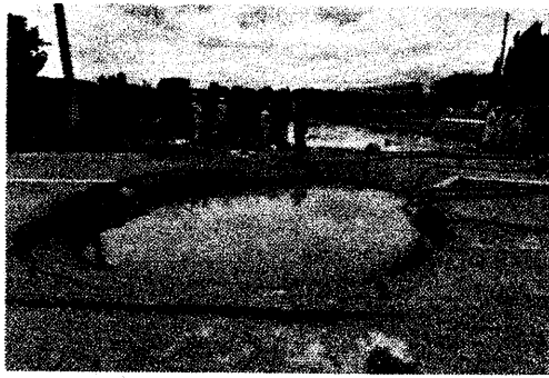
地震で水道管が破裂し、陥没した道路 (6月18日、大阪府高槻市)
