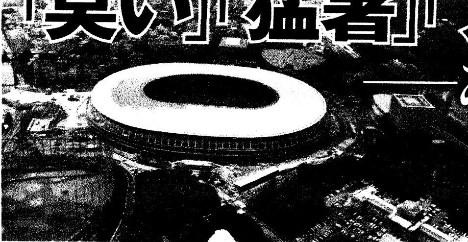
建設が進む新国立競技場＝6月25日
