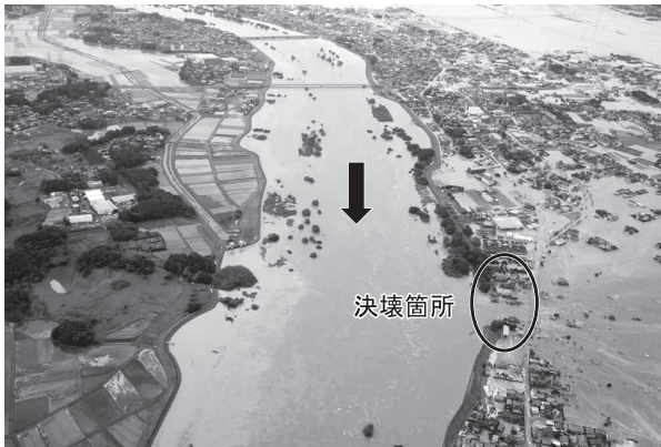
▲鬼怒川堤防の決壊（出所：国土交通省関東地方整備局資料を一部加工、2015年9月10日撮影）
