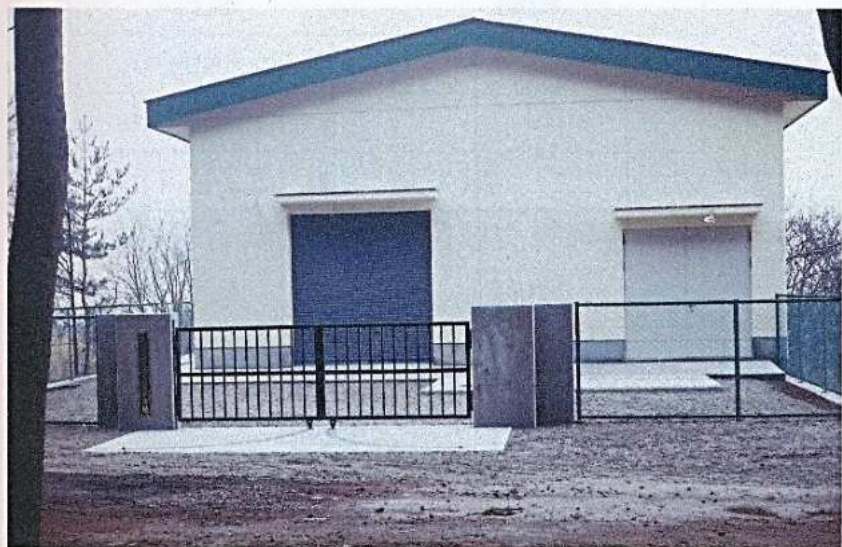
追分送水ポンプ場竣工（昭和53年2月）
