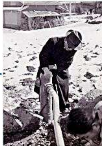
▲ 宮沢簡易水道の通水試験 (昭和 33 年)
